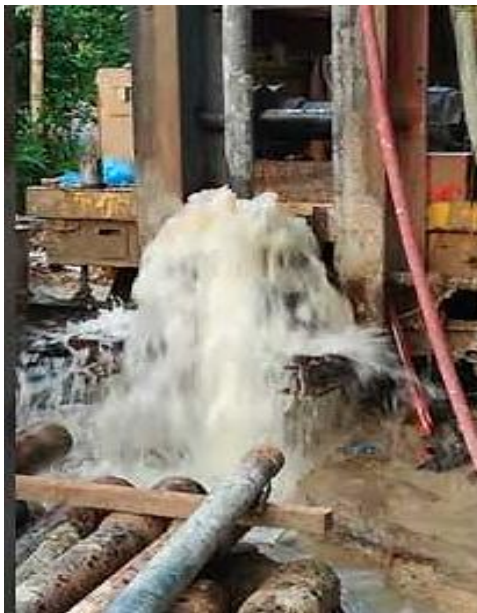
Figura 2: Perforación con aire comprimido y espumante
