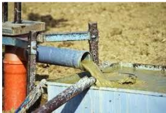
Figura 3: Perforando con circulación de lodos
