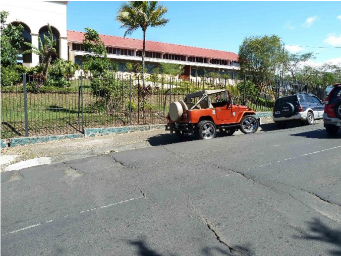
Figura 5. Fractura en el terreno que se refleja en la fisuración de la carpeta asfáltica y que continúa y afecta el templo católico "nuevo" de Santiago de Puriscal.
