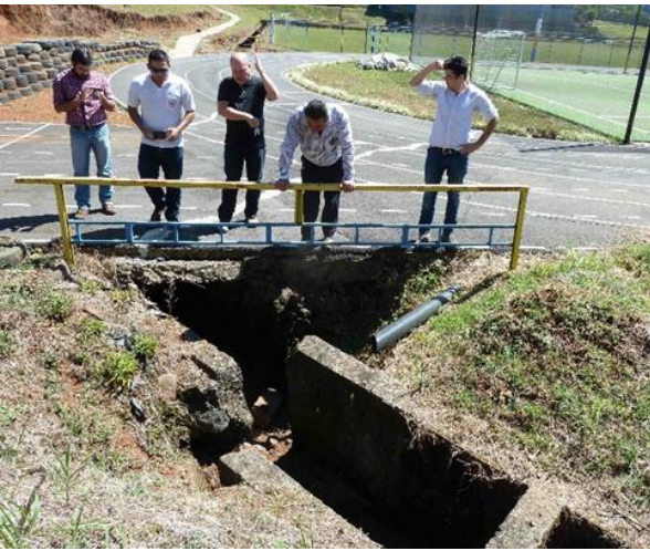
Figura 5. Fractura en el terreno que se refleja en la fisuración de la carpeta asfáltica y que continúa y afecta el templo católico "nuevo" de Santiago de Puriscal.
